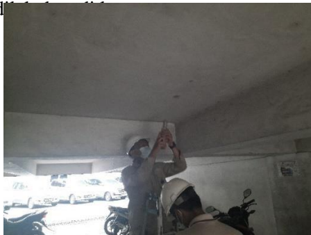
Gambar 2. Pengujian hammer test (Sumber : Dokumentasi pribadi, 2021)
